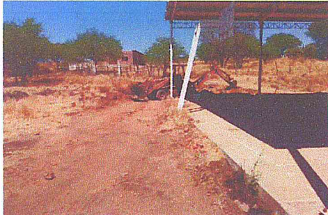
Nivelación en el área de la cancha de básquetbol de la comunidad de San Pedro para su ampliación y rehabilitación, para tener espacios públicos más dignos.
