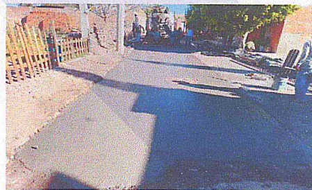
Pavimentación de la calle Allende 381.17 metros cuadrados Inversión: 396 mil 011.03 pesos
