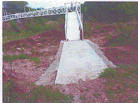
Para mejorar las condiciones de vida en El Zapote de Abajo, y para que puedan realizar sus actividades pese a las condiciones climatológicas, construimos la rampa para el acceso al puente peatonal de esta comunidad.
