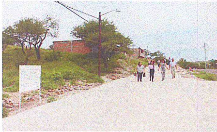
Pavimentación de la calle prolongación Allende 1 mil 157.08 metros cuadrados Inversión: 1 millón 423 mil 547.27 pesos
