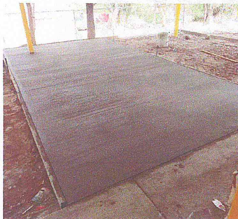
Apoyo con mano de obra en la Escuela Primaria 'Cristóbal Colón', de Arellanos con la pintura de las instalaciones, la ampliación de la cancha de usos múltiples y rehabilitación de las gradas de la cancha; es la muestra que seguimos apoyando a todas las instituciones educativas.
