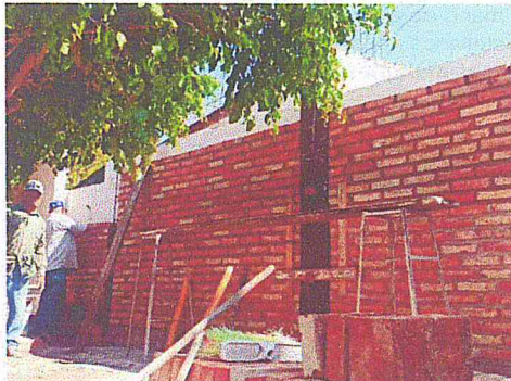
Se construyó un muro de tabique en las instalaciones de la Unidad Básica de Rehabilitación (UBR) , para evitar la filtración del agua en el muro vecino y futuros problemas con los cimientos de este edificio público.
